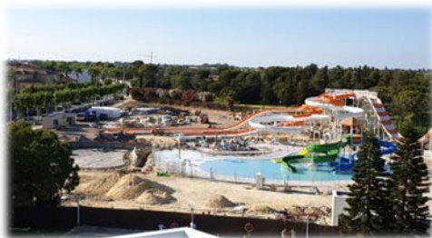
Construcción Parque Acuático Hotel Costa Ballena.
